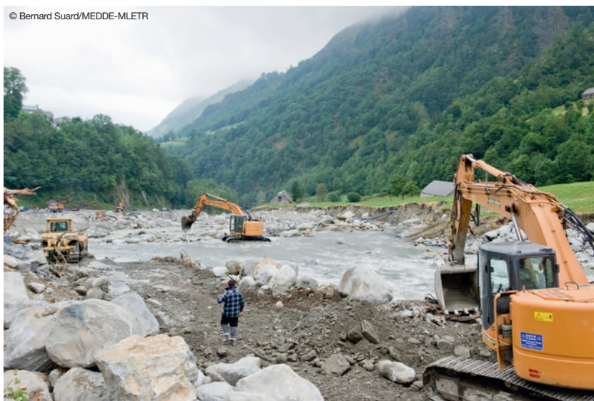
Reconstruction après les crues dans le village de Barèges (65) en juin 2013
